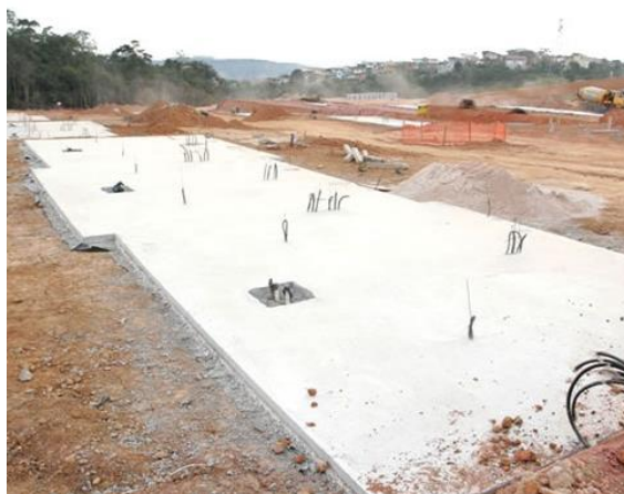
Figura 7 - Fundação nivelada contendo os arranques e as instalações sanitárias.
