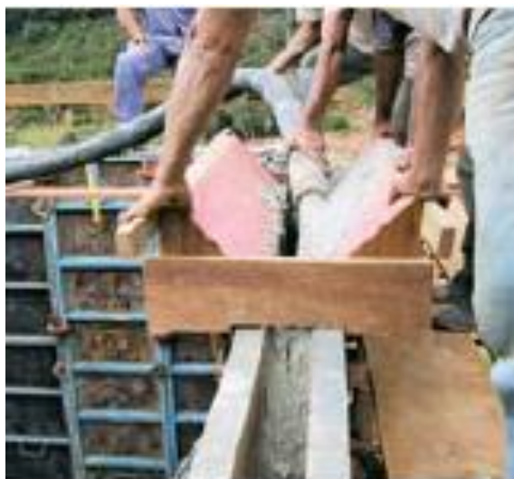
Figura 11: Concretagem Fonte: Comunidade da Construção
