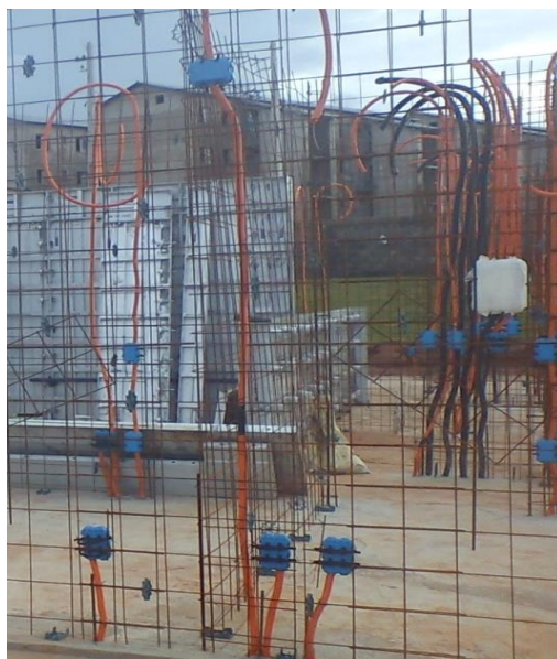
Figura 9 - Fixação dos eletrodutos e caixas elétricas. Fonte: Arquivo pessoal
