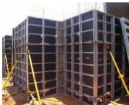
Figura 2: Fôrmas metálicas com compensados Fonte: ABCP
