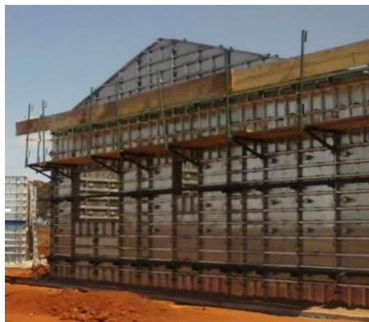
Figura 1: Fôrmas metálicas Fonte: arquivo pessoal
