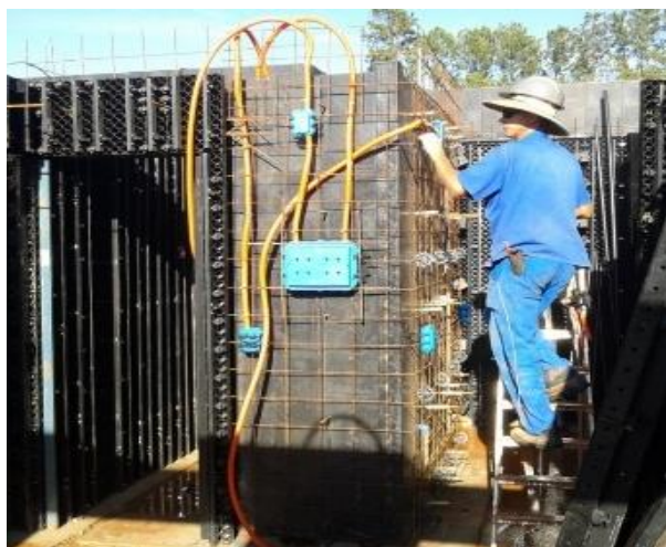
Figura 6 –Eletrodutos fixados na caixa elétrica que é posicionada com o auxílio da tela soldada
