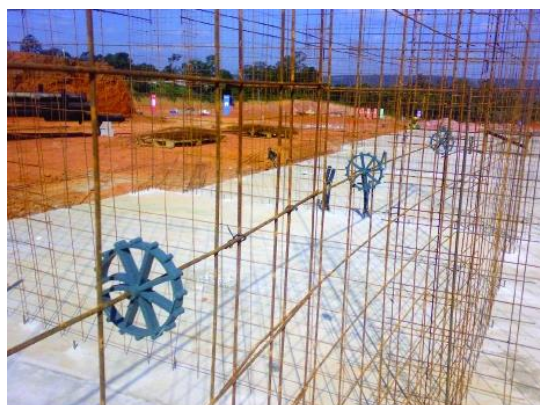
Figura 8 - Montagem das telas, reforços e fixação dos espaçadores.
