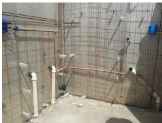
Figura 10 - Colocação das instalações hidráulicas Fonte: Arquivo pessoal
